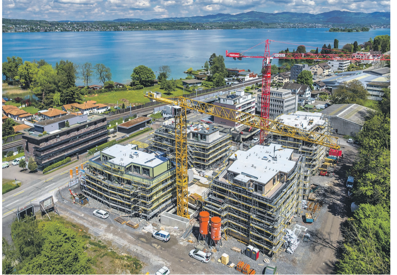
Die Baustelle im Obstgarten-Areal in Freienbach widerspiegelt das grosse Interesse an Wohnraum in Ausserschwyz.
